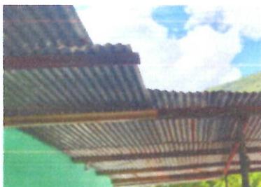
Foto 1: CUBIERTA DE LAMINA Sustitución de cubierta de techo con lámina galvanizada, Tipo de lámina: troquelada Calibre: 26, incluye: fijaciones y sellado en traslapes.
