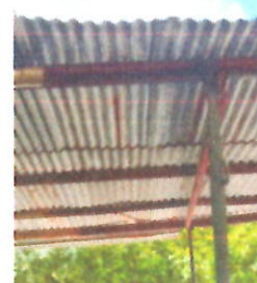
Foto 2: ESTRUCTURA DE TECHO Sustitución de estructura metálica para soporte de cubierta de lámina incluyendo perfiles para vigas, travesaños, sujeta con tornillería; corte, soldadura y anclaje de la estructura portante.
